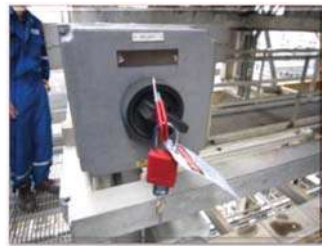
รูปแสดงการตัด-แยกไฟฟ้าภายในอาคาร (Substation)
