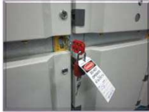
รูปแสดงการตัด-แยกไฟฟ้าภายในอาคาร (Substation)
